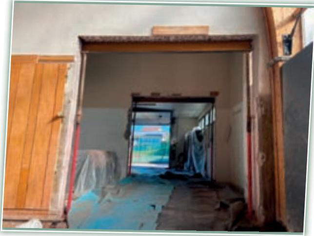
Création d'une ouverture plus importante pour permettre aux engins de chantier d'engager les travaux.
