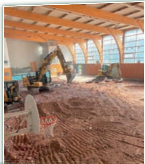
Mise en place d'un dallage et essais de plaque.
